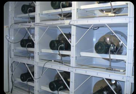
FANWALL TECHNOLOGY fan array
